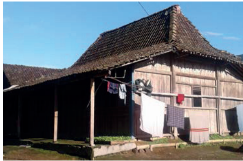
Foto 6. Bangunan Rumah Penduduk Berbahan Dasar Kayu
